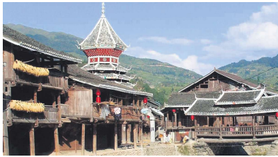
大图：加榜梯田 (123RF)；下图左：岜沙苗寨；下图右：占里侗寨
