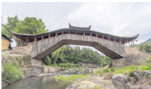
温州泰顺文兴桥，是一座清代编梁木拱廊桥。(Siyuz/wiki/CC BY 4.0)
