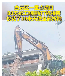
广州白云区“湾区智荟园”项目拆楼房场景。
